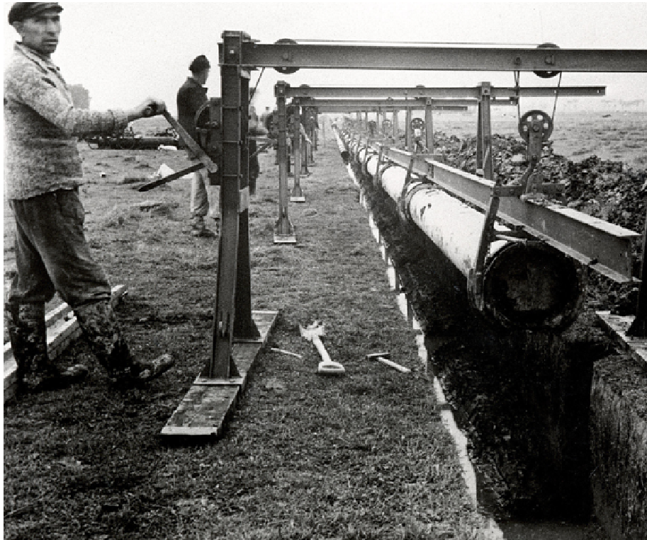
Rohrverlegung mit einer aufwändigen Hilfskonstruktion
